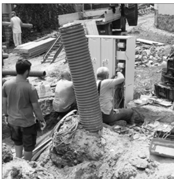
Przeniesienie przyłącza elektrycznego kościoła ze ściany do wolno stojącej skrzynki elektrycznej
