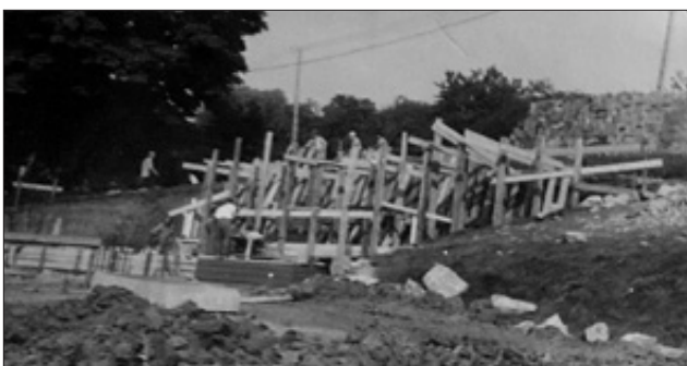
Murowanie ścian suterenu
