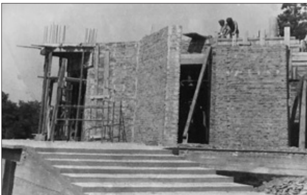
Prace zbrojeniowe przy pawlaczy
