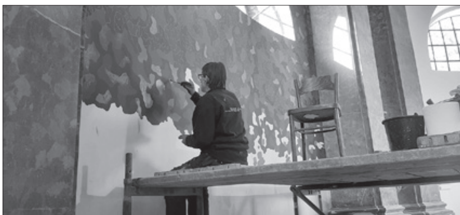
Pan Zbigniew Złotkiewicz przy żmudnym i czasochłonnym odtwarzaniu marmoryzacji ściany ołtarzowej
