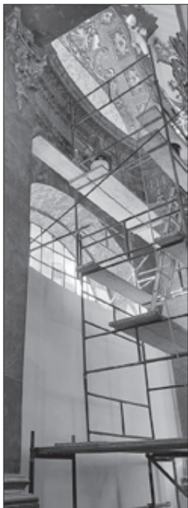
Prace związane z odtworzeniem marmoryzacji ściany ołtarzowej
