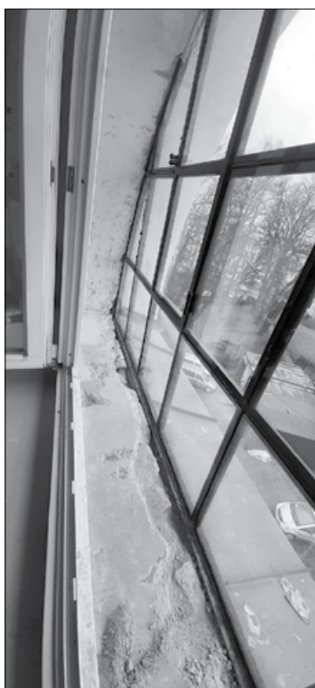
Okna po renowacji przed obróbką wewnętrzną
