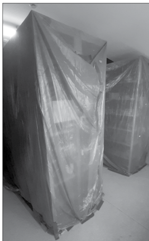
Zabezpieczenie regalów w archiwum na czas remontu
