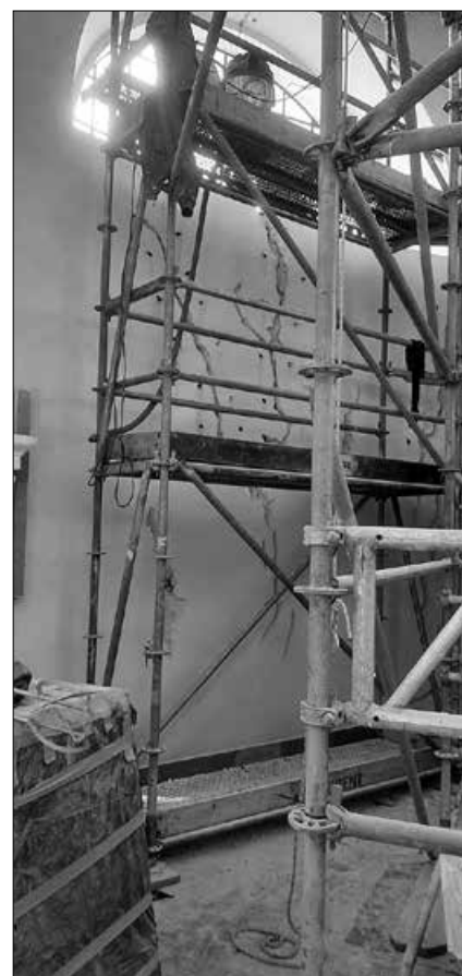
Prace w nawie oltarzowej
