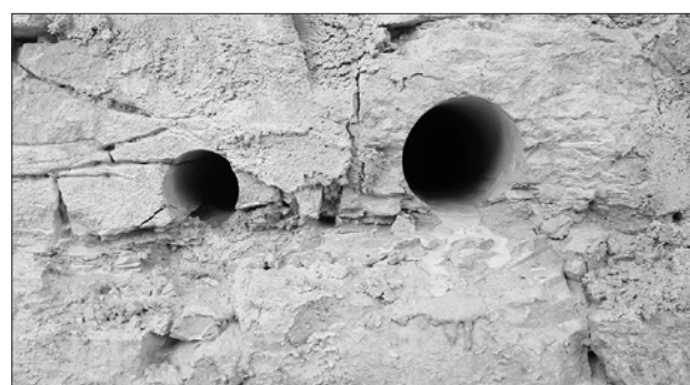
Przewierthy przez ściane pod instalację powiadamiania przeciwpożarowego
