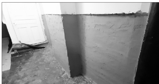
Specjalne tynki osuszające ściany na ścianach prawej nawy kościoła
