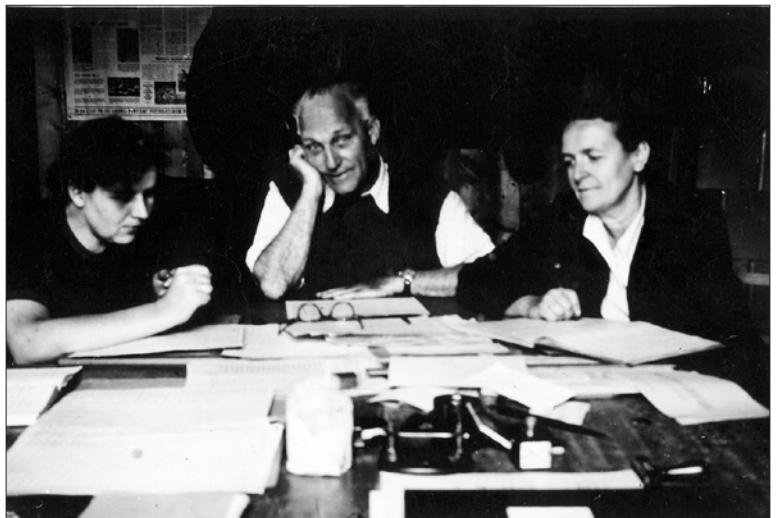
Stefa Michejda, budowa mostu; Wisła 1954
