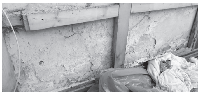
Zawilgocona ściana w zakrystii
