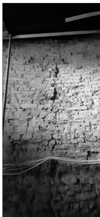
Pęknięcia ściany za ołtarzem
