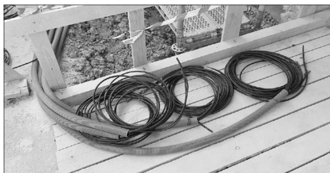
Rozprowadzanie przewodów do instalacji powiadamiania przeciwpożarowego
