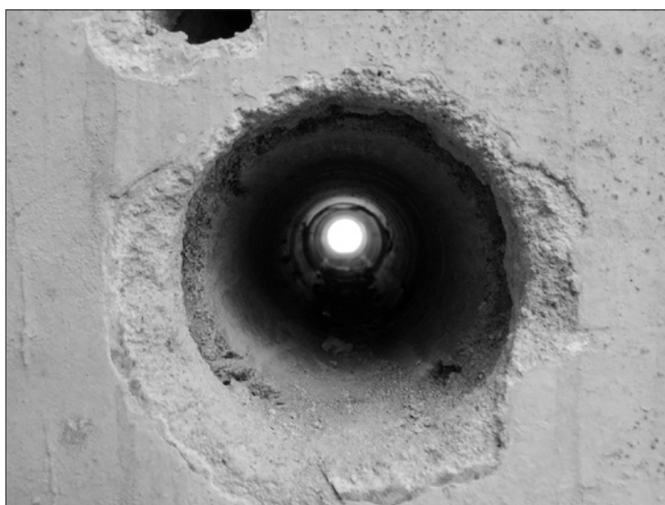
Jeden z otworów do instalacji powiadamiania przeciwpożarowego
