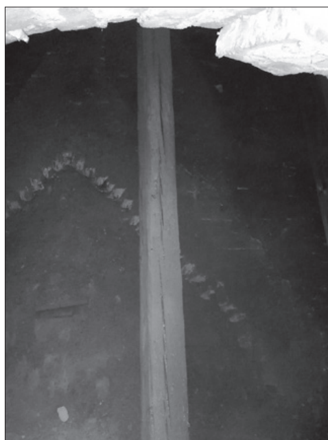
Odkryte w trakcie skuwania tynku okno techniczne, widoczne fragmenty belek więźby i sklepień kościoła 2
