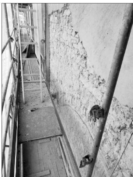
W trakcie skuwania tynków ścian bocznych kościoła 2
