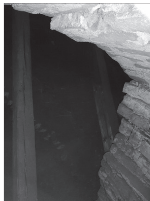
Odkryte w trakcie skuwania tynku okno techniczne, widoczne fragmenty belek więźby i sklepień kościoła
