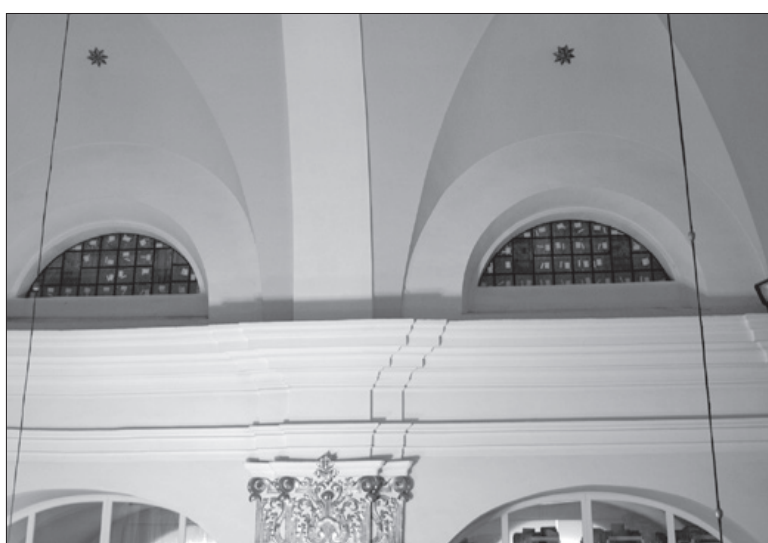
Dwa pierwsze okna po zasklepieniu foto Marcin Gabryś
