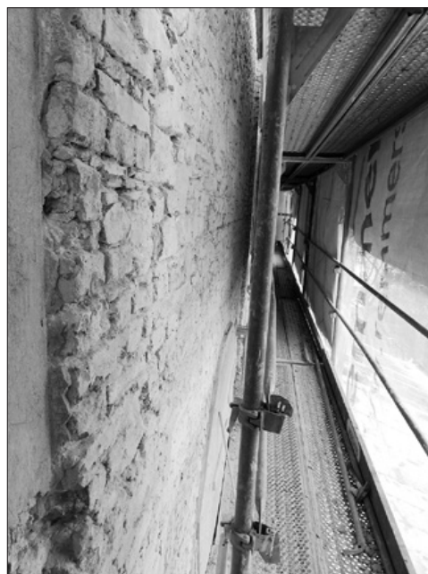
Mury kościoła przed piaskowaniem
