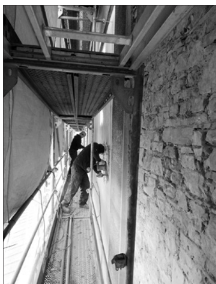
W trakcie skuwania tynków ścian bocznych kościoła
