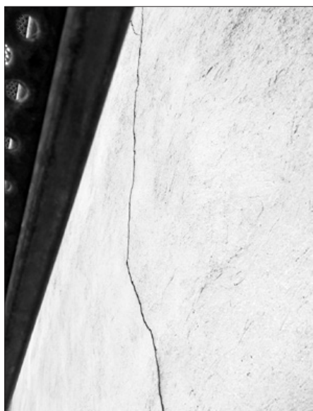
Pęknięcia elewacji w partiach górnych kościoła
