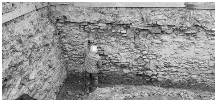
Czyszczenie fundamentów kościoła fot Marcin Gabrys
