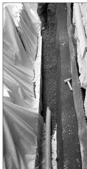
Żelbetowa opaska i nowy drenaż, fot.mg
