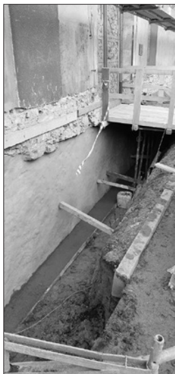
Uzupełnianie i zabezpieczanie fundamentów fot. mg
