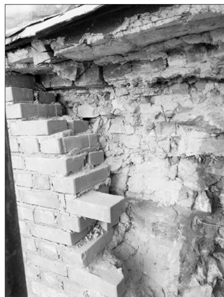
Zamurowywanie miejsc pęknięć ścian po ich zabezpieczeniu fot.po
