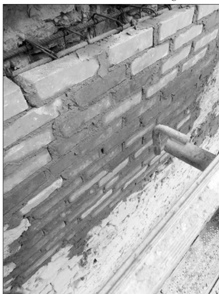
Zamurowywanie miejsc pęknięć ścian po ich zabezpieczeniu fot.po
