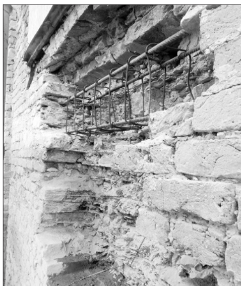
Zbrojenia zabezpieczające pęknięcia ścian, fot.po
