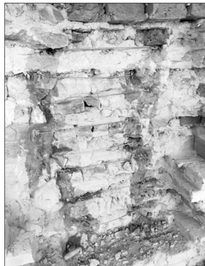
Zabezpieczanie pęknięć kotwami chemicznymi, fot.po
