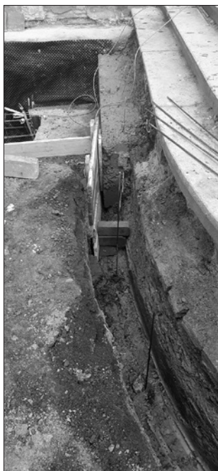
Wykop pod fundament pierwszego stopnia schodów frontowych fot. mg
