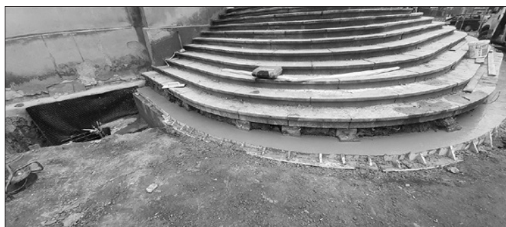
Fundament pierwszego stopnia schodów frontowych fot. mg
