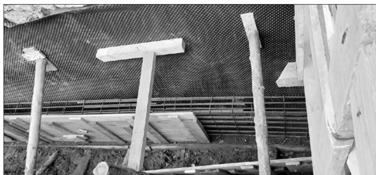
Przygotowanie żelbetowej opaski, fot. mg
