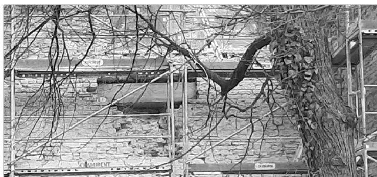
Zbrojenia pęknięć pod oknami i uzupełnienia ubytków, fot. mg
