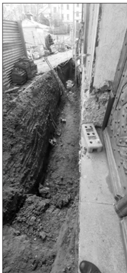
Etap ostatni odkopywania fundamentów kościoła, fot. mg
