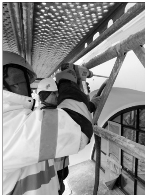
Montaż kolejnych kotw spinających pęknięcia fot. P.Orłowski
