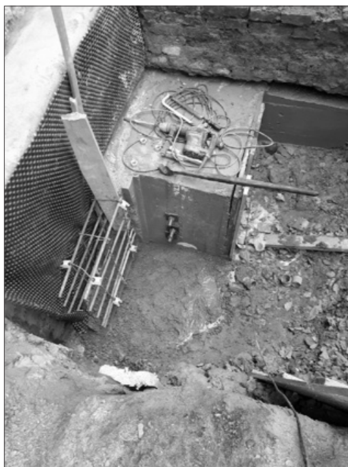
Fragment żelbetowej opaski fot. mg
