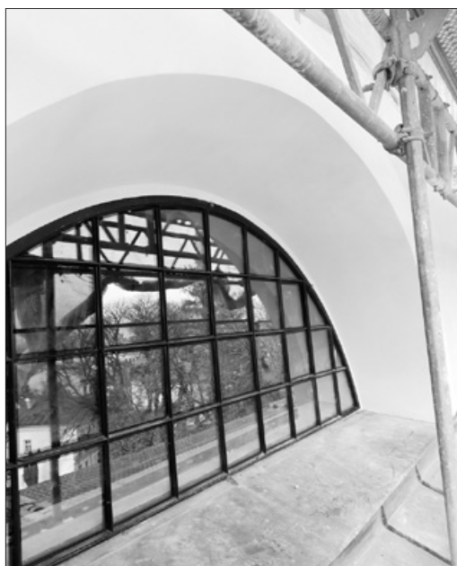
Odnowione okiennice z nowymi podwójnymi szybami fot. P.Orłowski
