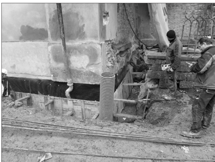
Zalanie betonem opaski żelbetowej fot. mg
