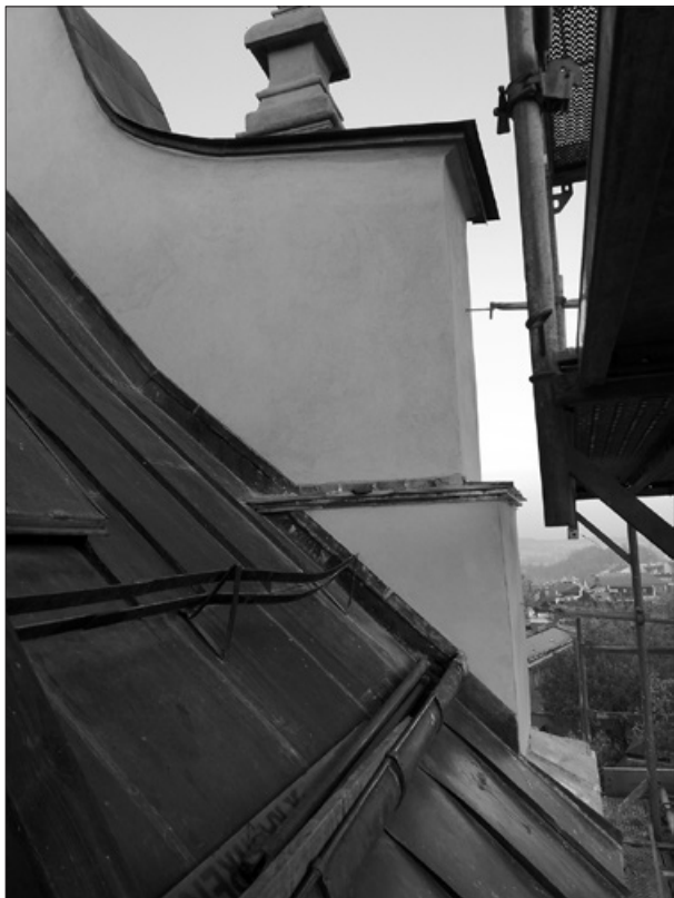
Nowe tynki i obróbki dekarские na ścianach przy wieży fot. P.Orłowski
