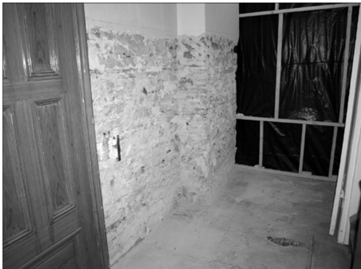
Skute ściany wewnątrz kościoła od strony południowej. fot. mg
