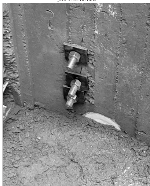
Śruby spinające paske żelbetową pod schodami głównymi fot.mg
