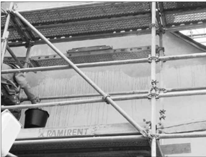
Hydroizolacja nowych tynków
