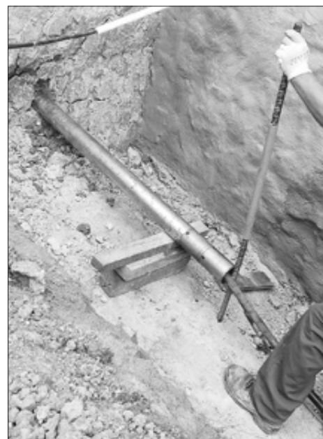
Wykonywanie odwiertów pod schodami głównymi kościoła
