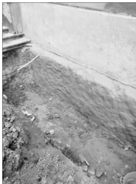
Zaizolowane fundamenty po odczyszczeniu
