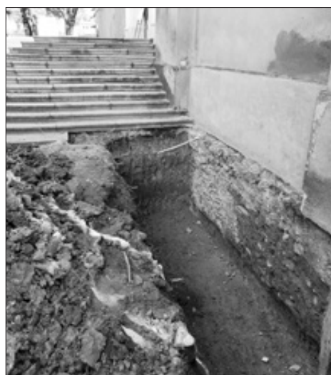
Odkopywanie fundamentów wieży przy schodach głównych
