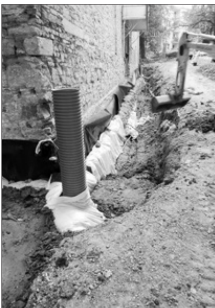
Nowe drenaży od strony południowej kościoła
