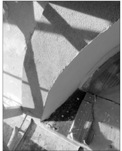
Prace tynkarskie i wykończeniowe na ścianach kościoła
