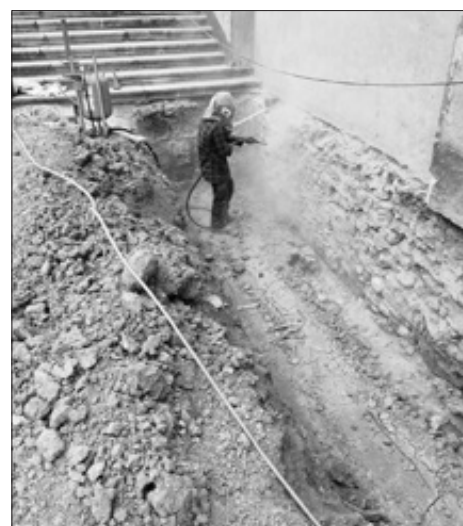
Piaskowanie fundamentów przy wieży
