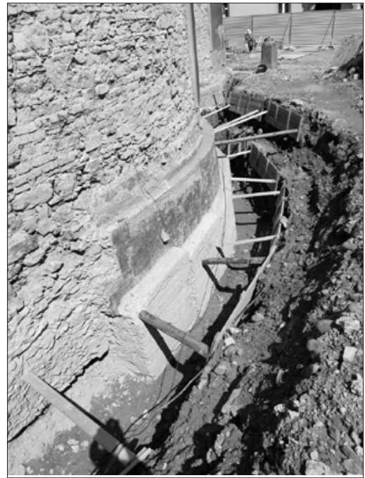
Zaizolowane fundamenty
