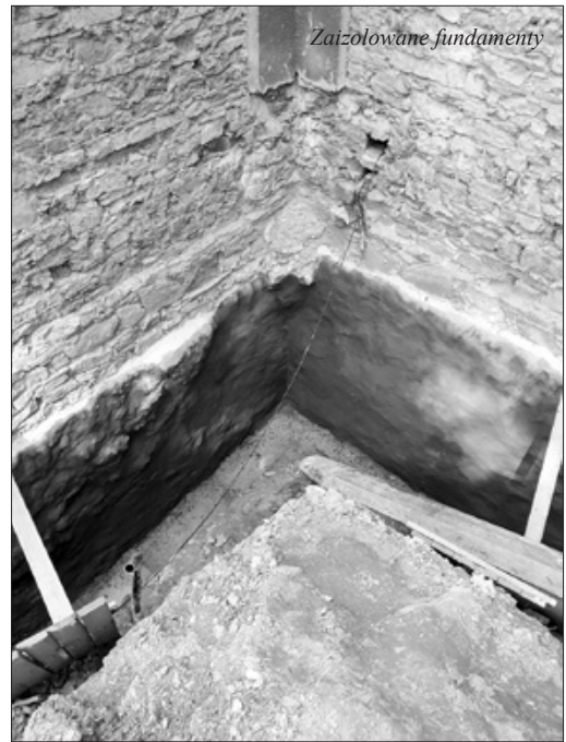
Zaizolowane fundamenty
