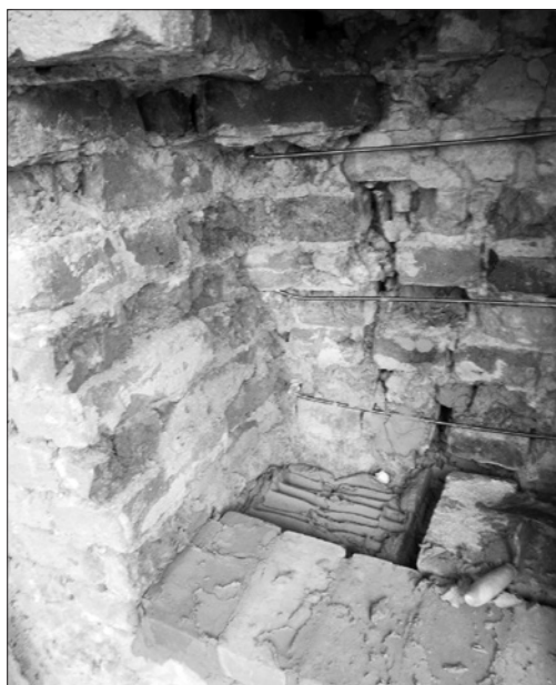
Montaż kotw spinających
