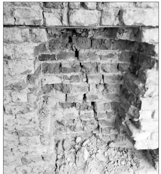
Pęknięcia ścian
