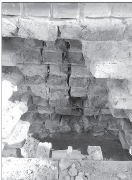
Montaż kotw spinających
