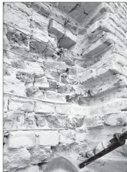
Montaż kotw spinających
