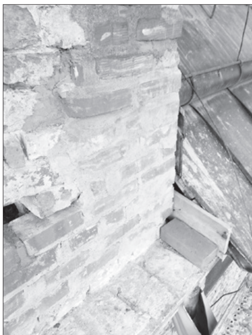
Uzupełnione ubytki cegieł na wieży
