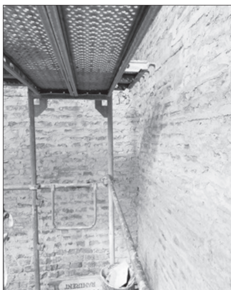
uzupełnianie zapraw między cegłami
