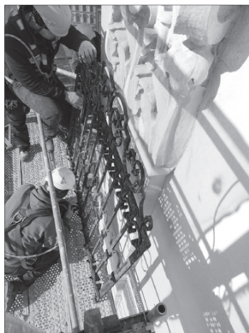
Demontaż balustrad z latarni pod hełmem
