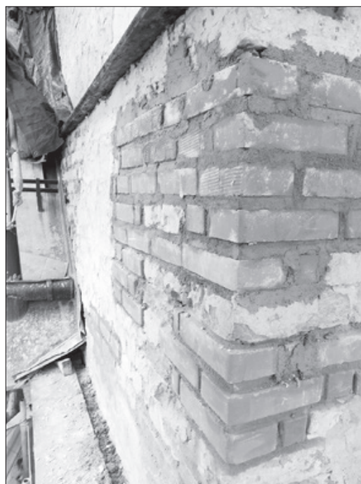
Uzupełnione ubytki cegieł na wieży
