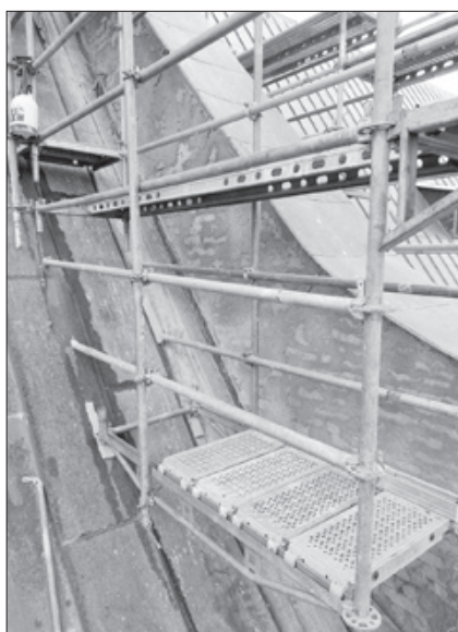
Prace tynkarskie na wieży
