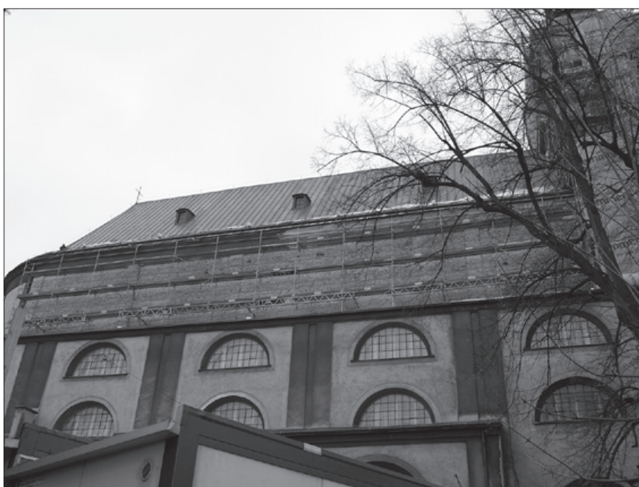
Skute tynki części górnej - ściana północna
