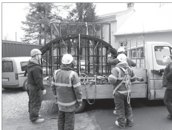
Przywóz okien po renowacji wraz z nowymi szybami
