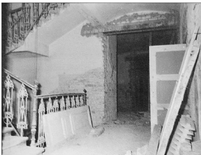
Wnętrze budynku szkoły przed przystąpieniem do remontu
