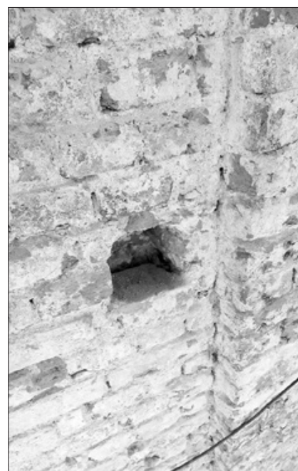
Otwory po dawnych rusztowaniach budowlanych
